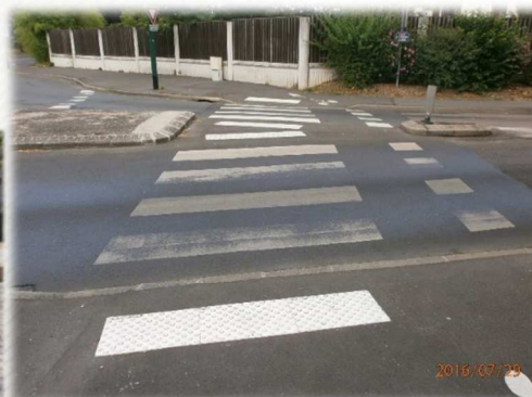
Traversée de chaussée
